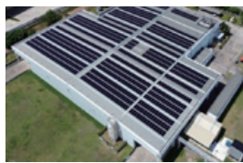
OILES (THAILAND) CO., LTD. PPAによる太陽光発電
