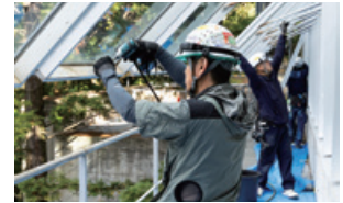
改修工事の様子
