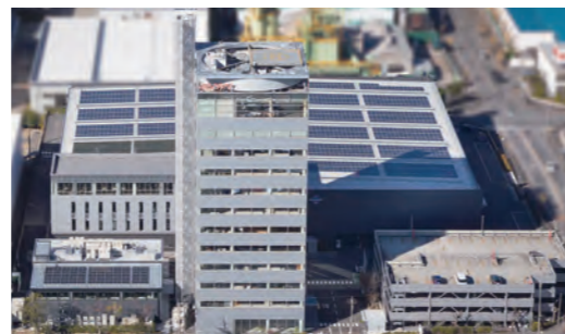
大阪事業所の太陽光パネル
