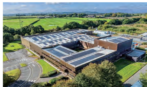
イギリス拠点の太陽光パネル
