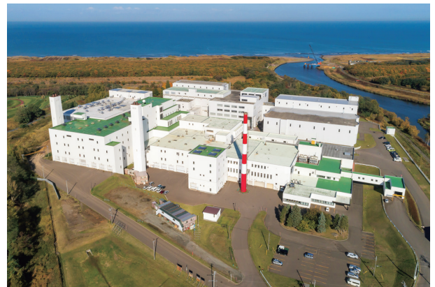
汚泥焼却プラント (札幌市西部スラッジセンター)
