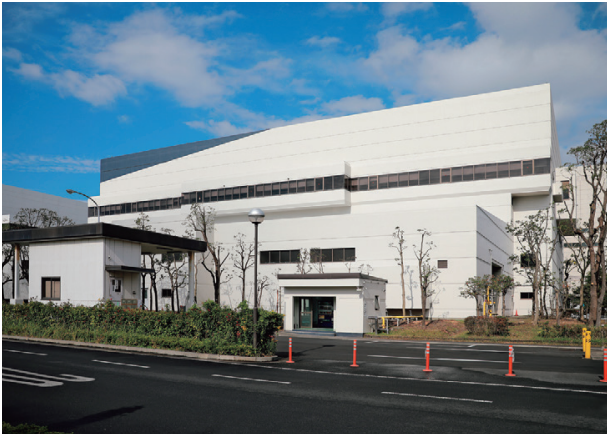
一般廃棄物処理プラント （大田清掃工場第一工場）
