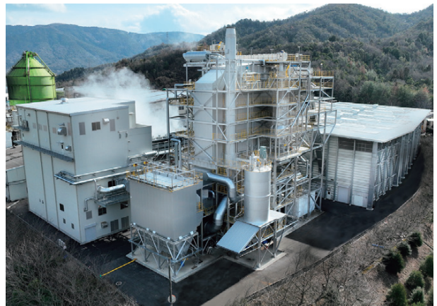
バイオマス発電プラント
