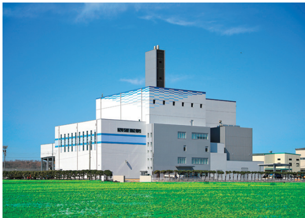
一般廃棄物処理プラント
