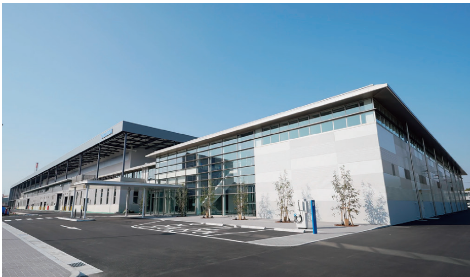
新工場およびはりまオフィス（事務所棟）外観
