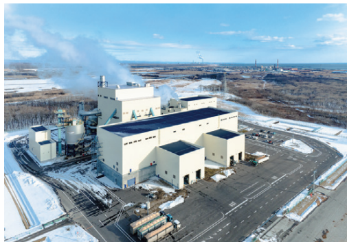
勇払バイオマス発電所
