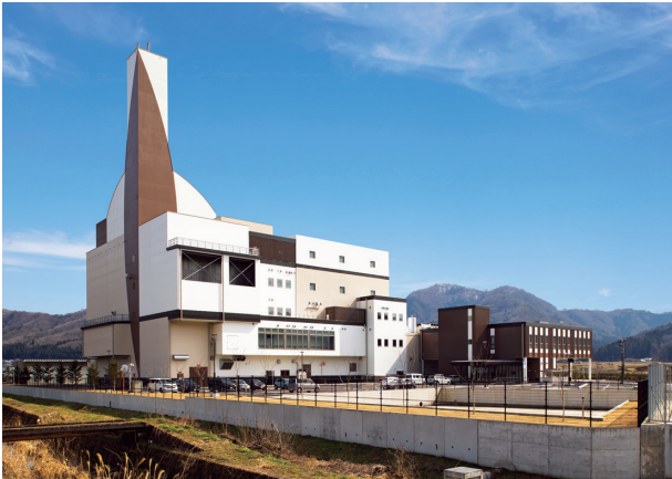
一般廃棄物処理プラント
