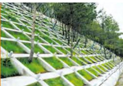
フリーフレーム工法は、合理的な金網型枠の特性と吹付工法の特徴を活かして、切土法面・自然斜面などに連続した枠を造る工法です。斜面の安定を図ると共に緑化工などを施工することによって、自然環境との調和を大切にした工法として広く採用されています。
