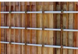
型枠一本締め工法は、コンクリート構造物の施工に不可欠な型枠工事における新工法で、この分野における70年ぶりの技術革新です。鹿島建設株式会社、株式会社丸久、株式会社楠工務店と共同開発し、2024年8月に発売しました。
