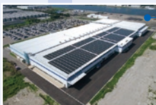
新湊東工場竣工
