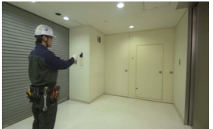
防火設備定期検査の実施風景
