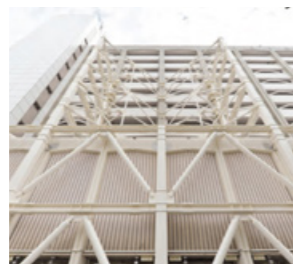
ビルの耐震補強工事
