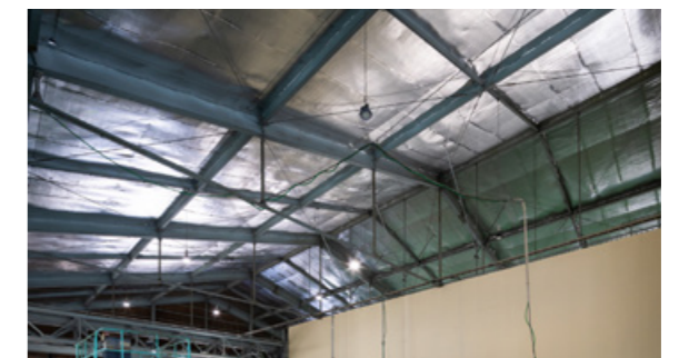
熱中症対策として工場へ設置した屋内用遮熱シート「はるクール」
