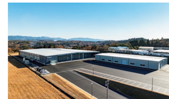
マル中産業株式会社 倉庫棟新築工事
