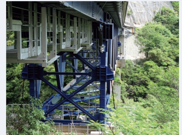
千切橋（せんじんばし） 座屈拘束ブレース設置状況
