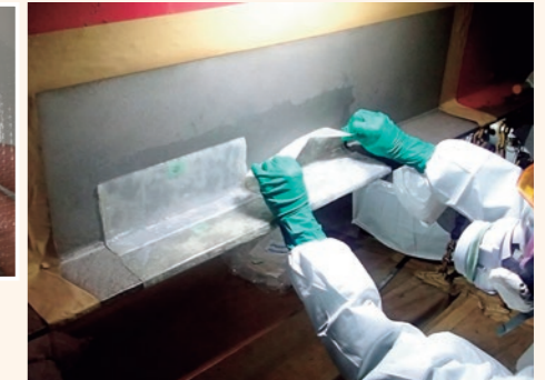
脱塩シートとシートの貼り付け状況
