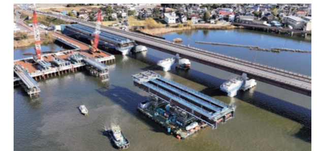
神宮橋 台船架設
