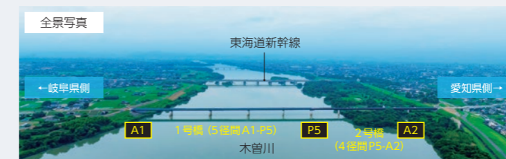
令和7（2025）年5月24日に開通した新濃尾大橋。上流の濃尾大橋の慢性的な渋滞の解消に加え、物流の活性化や災害時の緊急輸送道路としての役割も期待されています。
