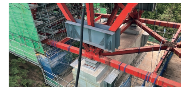
阿能川橋 支承受換完了
