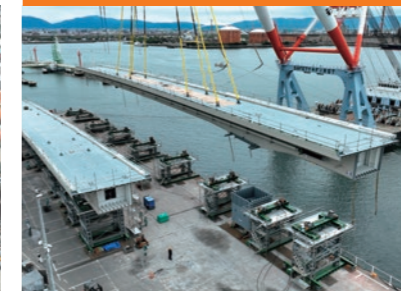
栈橋上での柱部材との連結
