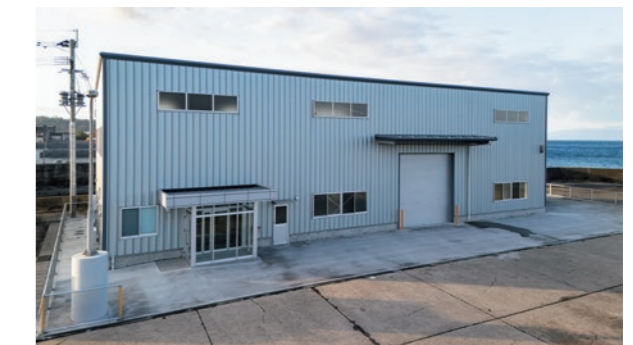
ベルテクネ(株)南九州営業所 新築工事
