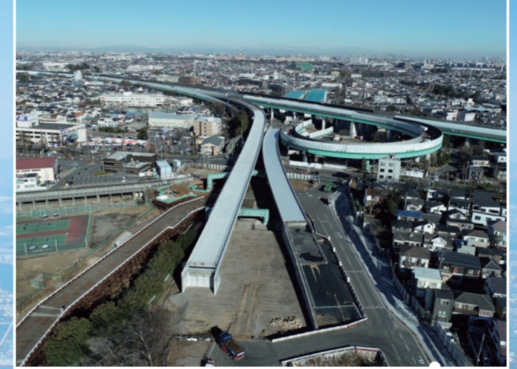
東京外かく環状道路 大泉ジャンクション
