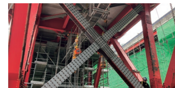
阿能川橋 対傾構補強
