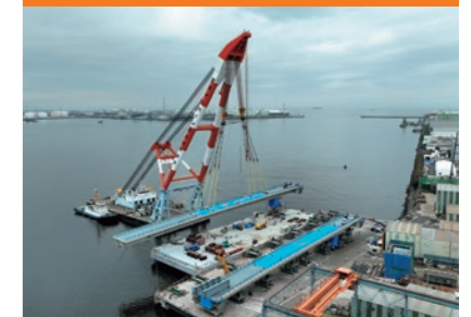
浜出し作業 (台船への搭載)
