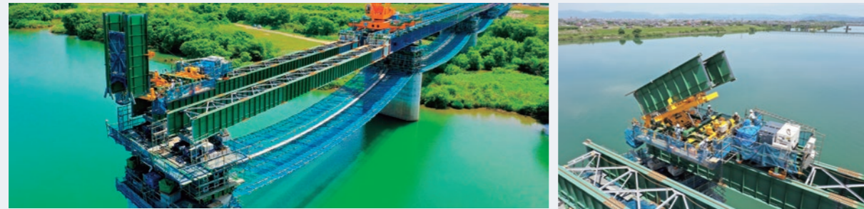
「後方回転・自走式手延機解体装置」で手延機解体中の新濃尾大橋
