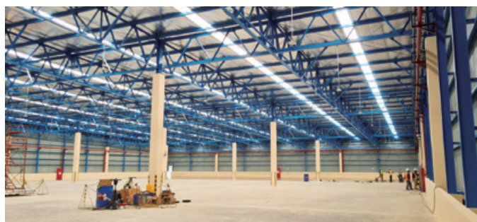
建設中の建屋の様子
