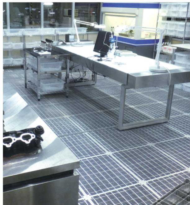
1962年、アーレスティは日本で最初のアリミニウムダイカスト製のフリーアクセスフロアパネル「モバフロア」を開発しました。フリーアクセスフロアとは、配線・配管を床下に納める二重床システムのことです。一般的にはオフィスや病院などに幅広く利用されていますが、当社では特に半導体生産工場などのクリーンルームやデータセンター、コンピューター用フロアパネルに注力しており、クリーンルーム向けでは、国内No.1となるシェア70%以上を誇っています。
