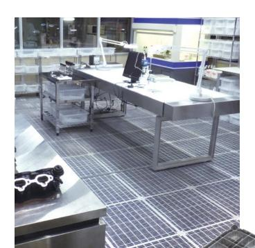
1962 年、アーレスティは日本で最初のアルミニウムダイカスト製のフリーアクセスフロアパネル「モバフロア」を開発しました。フリーアクセスフロアとは、配線・配管を床下に納める二重床システムのことです。一般オフィスや病院などに幅広く利用されていますが、当社では特に半導体生産工場などのクリーンルームやデータセンター、コンピュータルーム用フロアパネルに注力しています。
