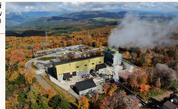
安比地熱発電所 定格出力：14,900kW 事業主体：安比地熱(株)
