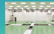
クリーンルーム：パネル材x施工
