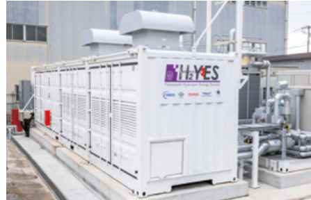
500kWワンパック P2Gシステム ※画像提供：東京電力エナジーパートナー株式会社
