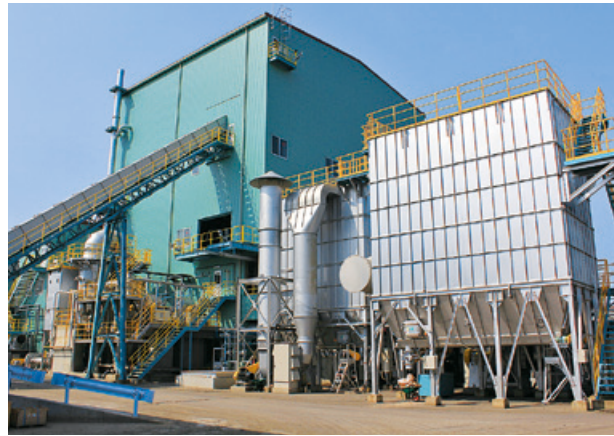
焼却灰溶融炉建屋 【設備投資額】 約19億円 【増設工事着工】 2021年4月 【焼却灰処理能力】 約35,000トン/年 【営業運転開始】 2022年10月予定
