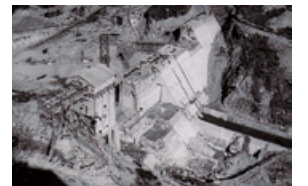
1953年9月 建設中のダム
