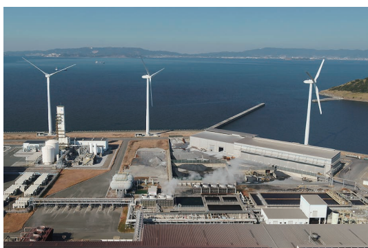
田原工場の圧延水処理設備
