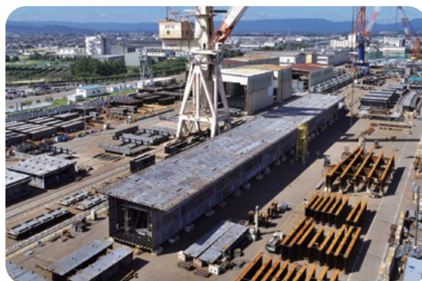
▲ムンバイ湾横断道路建設事業に用いられた橋梁ブロック
