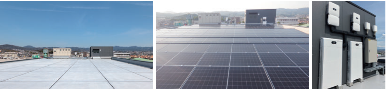
(株)エーアンドエー大阪 新管理棟太陽光発電設備設置前(写真左)、設置後(写真中央・右)
