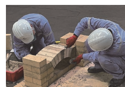
築炉試験練習による技能伝承
