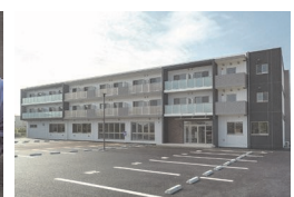
中野寮（千葉県君津市） 2023 年 3 月竣工
