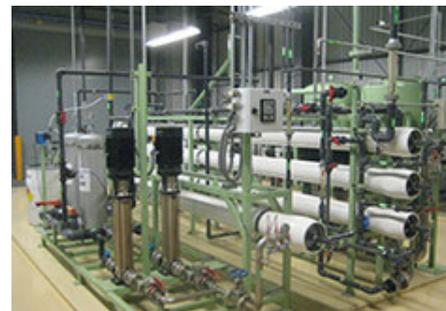
逆浸透膜を用いたろ過装置
