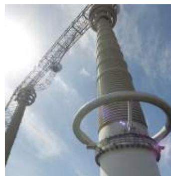
世界最大級の変電用ガイシ（全長11m）を用いたブッシング。高度な設計、製造技術により100万ボルトの高電圧や大地震にも耐え、長期の信頼性を誇ります。
