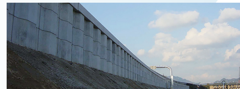
美濃関ジャンクション工事
