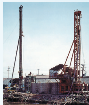
寝屋川護岸工事
