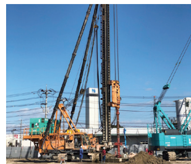
既製コンクリート杭工事
