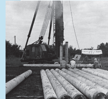
ONAパイルのハンマー打撃試験
