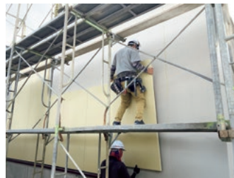
「QDパネル鉄骨外張り断熱システム」施工風景
