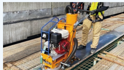
※3 協力会社との橋梁床版下H鋼表面切削における共同 技術開発の様子
