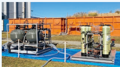
※2 PFAS 浄化装置設置状況
