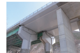
コンクリートはく落防止
