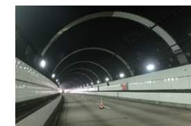
トンネル改修
