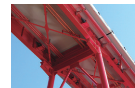
鋼板補強工事
