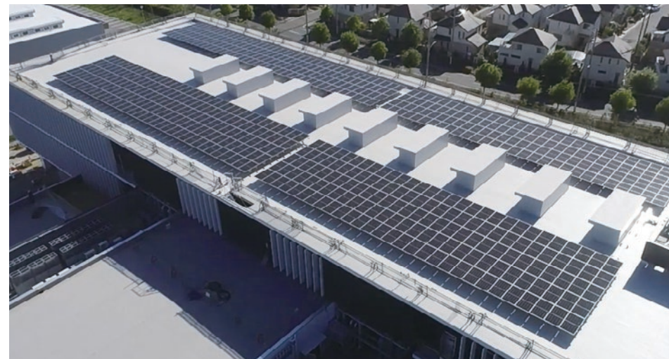
神戸サイエンスパークセンター事務棟の屋上全面に設置されている太陽光発電
