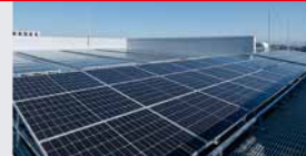
太陽光パネル設置
