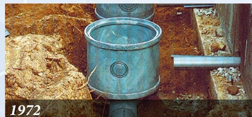
1972 土中においても変質しない高い耐久性を誇るポリプロピレン製排水ます
