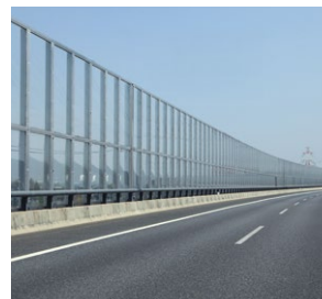
道路用資材 「ポリカーボネート製透光板」 (新東名高速道路)
