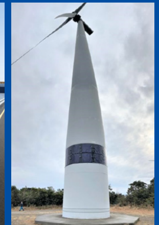
風力発電タワーへの設置
