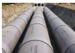
雨水貯留管としても活躍する強化プラスチック複合管
