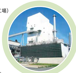
関東工場(勝田)の 木質バイオマスボイラー
