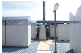
屋上に引き上げた室外機
