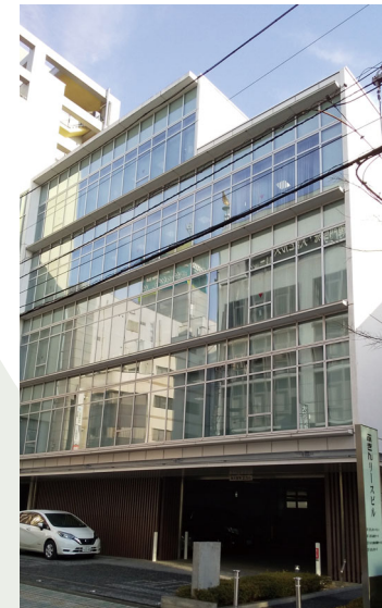
ぶぎん総合リース株式会社様本社ビル
