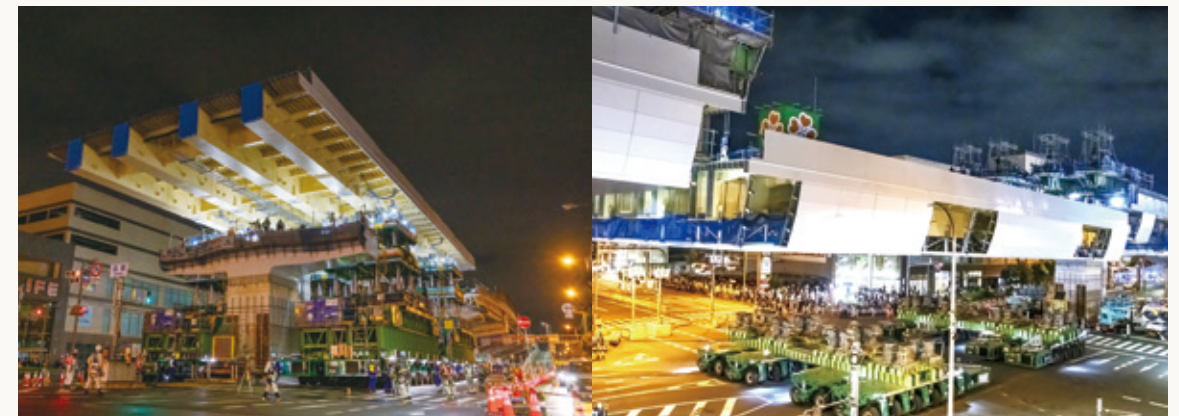
側径間の送出し架設状況
