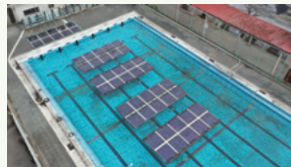
浮体式ペロブスカイト太陽電池
