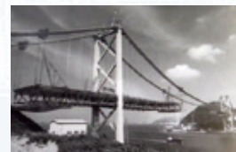
架設中の関門橋
