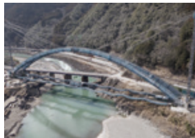
鎌瀬橋の架設状況
