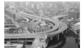
江戸橋ジャンクション(完成後)
