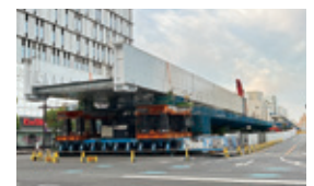
広電広島駅高架化関連工事
