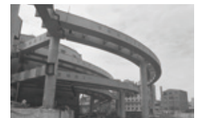
江戸橋ジャンクション(架設中)
