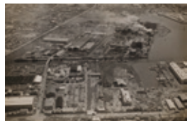
砂町第1・第2工場
