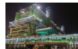
中国自動車道 石橋跨線橋(下り線)
