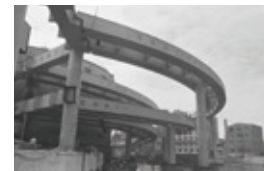
架設中の江戸橋ジャンクション
