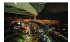
海老江工区鋼桁および鋼製橋脚工事
