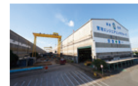
宮地エンジニアリング(株)千葉工場
