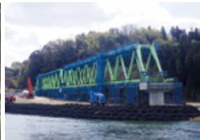
球磨川第四橋梁(TT3/TT4)の架設状況
