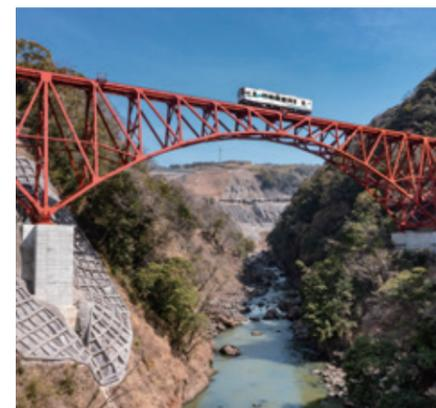
南阿蘇鉄道第一白川橋りょうは、白川渓谷を跨ぐ単線鉄道橋で、2ヒンジスパンドレル・ブレースド・バランスドアーチと呼ばれる日本でも希少なアーチ橋として昭和2年に完成しました。先人たちの貴重な技術とその優れた景観美から、平成27年度に選奨土木遺産として選出されましたが、翌年に発生した熊本地震により甚大な被害を受けたため、新橋へ架け替えることとなり、エム・エムブリッジ(株)が旧橋撤去から新橋の設計、製作、架設までを請け負いました。
