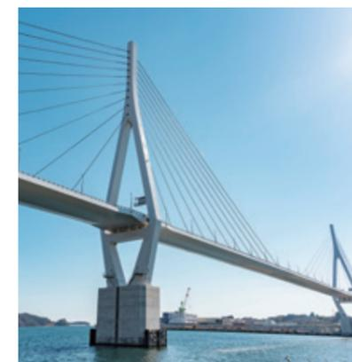
気仙沼湾横断橋は、エム・エムブリッジ(株)、宮地エンジニアリング(株)、川田工業(株)の三社からなるJV\*で併合橋を含む東側半分を施工した最大支間長360mを有する鋼3径間連続斜張橋であり、東北地方では最大規模の長大橋です。架設工法は高度な技術力や経験が求められる特殊工法が採用され、3000t吊起重機船を用いた主塔大ブロック架設や、主塔近傍では600t吊起重機船を用いた大ブロック架設を行い、そこから直下吊設備を用いて主桁バランス架設を行いました。
