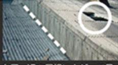
台風一過の屋根が上がって見ると、痛々しい爪痕が残る屋根(点線より右)のすぐ隣のSOSEIで補強された屋根(点線より左)は、ほぼ無傷でした。
