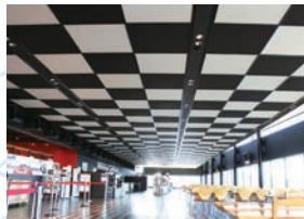
超軽量天井材 「かるてん」で 地震災害時の 天井落下 リスクを軽減
