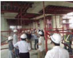
現場巡回を通じた、施工不良の回避
