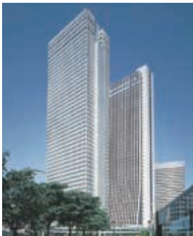
新宿野村ビル 1978年竣工 延床面積:58,512㎡ ※1
