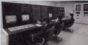
当時の新宿野村ビル防災センター
