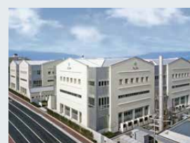
フジコー本社(兵庫県伊丹市)
