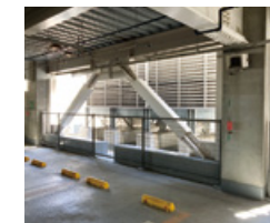
耐震補強事例
