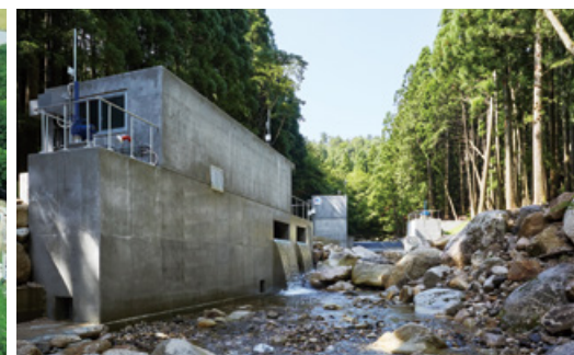
鴨川小水力発電所
