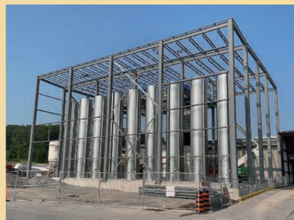
建設中のキャンベルフォード工場の新ライン(カナダ)
