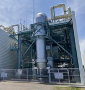
横浜磯子事業場で稼働開始した水素混焼対応型コージェネレーションシステム
