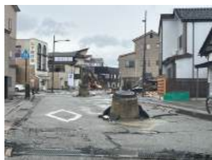
能登半島地震において浮上したマンホール(液状化)
