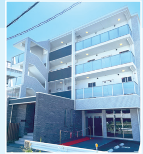
竣工した賃貸マンション
