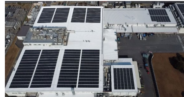
唐津工場(佐賀県唐津市)
