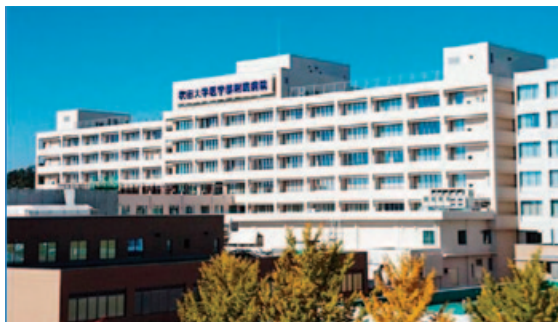
秋田大学(医病)病棟改修 空調工事
