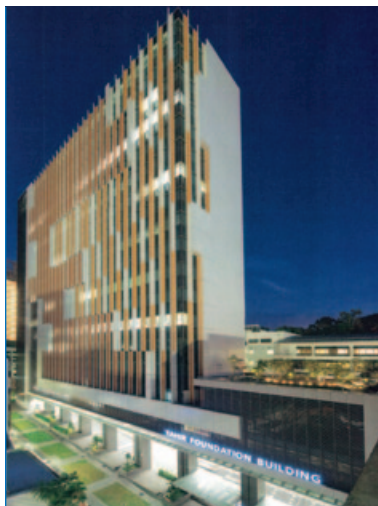
シンガポール国立大学薬学棟 MD1 電気工事
