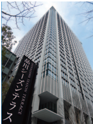
品川シーズンテラス 空調工事
