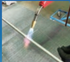
アルミ冷媒配管用 ろう付工法開発
