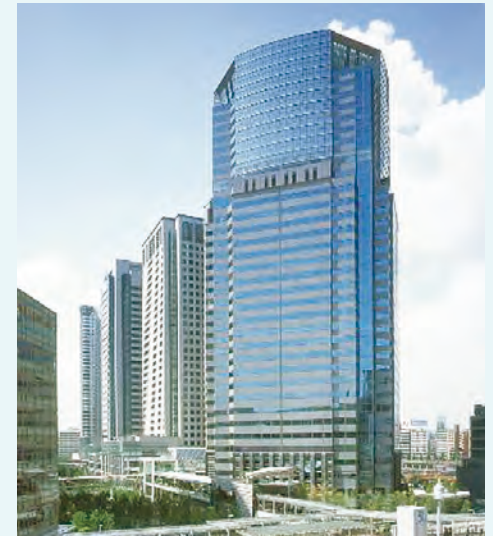
品川イーストワンタワー（大東建託本社ビル）
