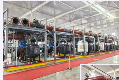
プレハブユニット施工例
