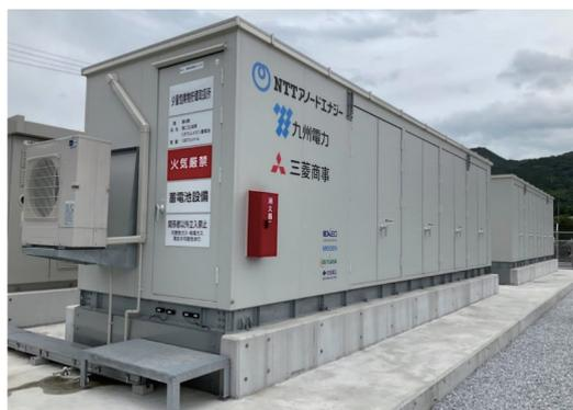
当社はNTTアノードエナジー株式会社様、九州電力株式会社様及び三菱商事株式会社様による再生可能エネルギー（以下「再エネ」）の主力電源化並びに再エネ出力制御の低減に向けて福岡県田川郡香春町における出力 1.4MW/容量 4.2MWhの蓄電システムの本格的な運用開始に際し、系統用蓄電池システムのEPC（設計・調達・建設）を実施しました。
